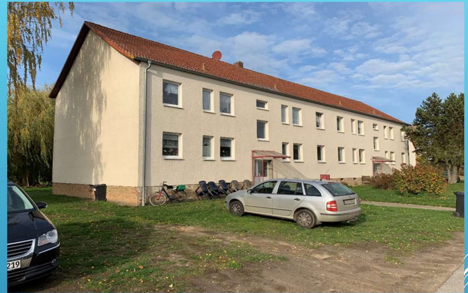
Haus-Nr. 7-9 vor der Sanierung
