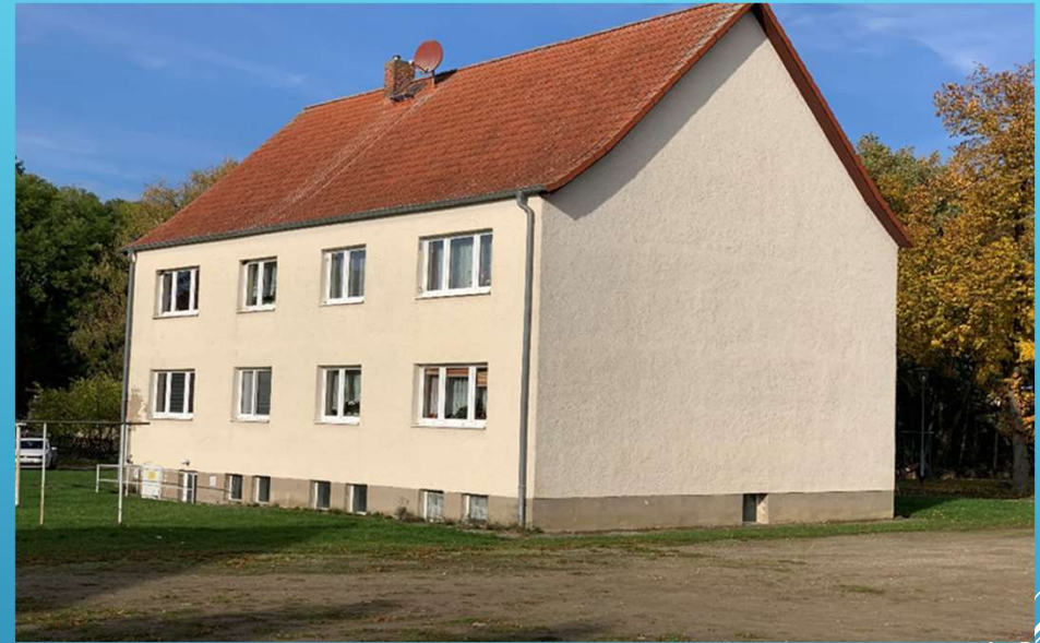
Haus-Nr. 11 vor der Sanierung
