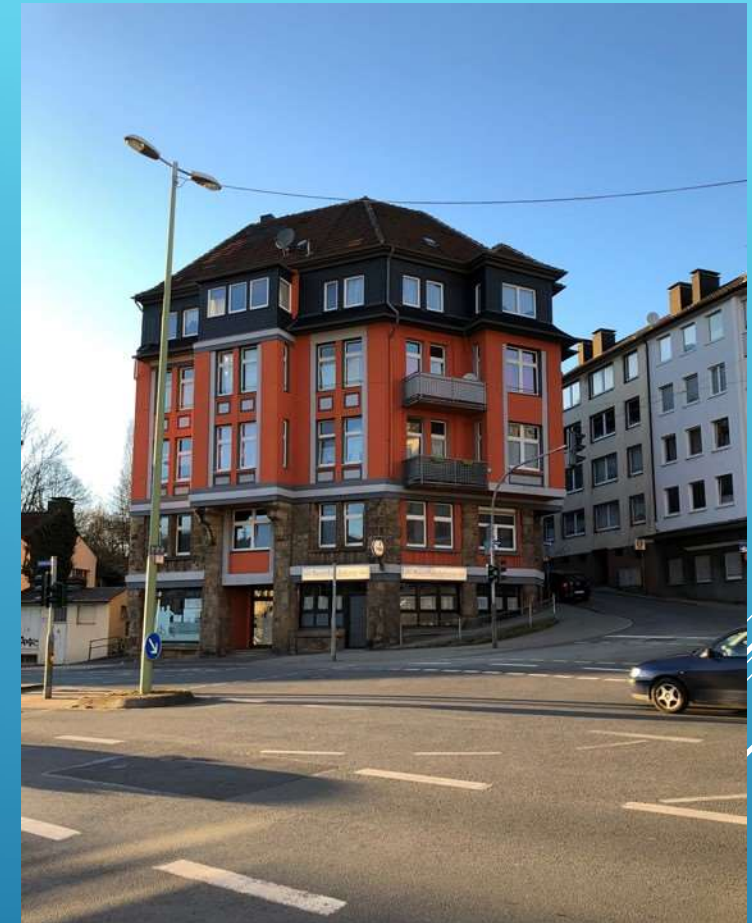
Objektfoto vor der Sanierung
