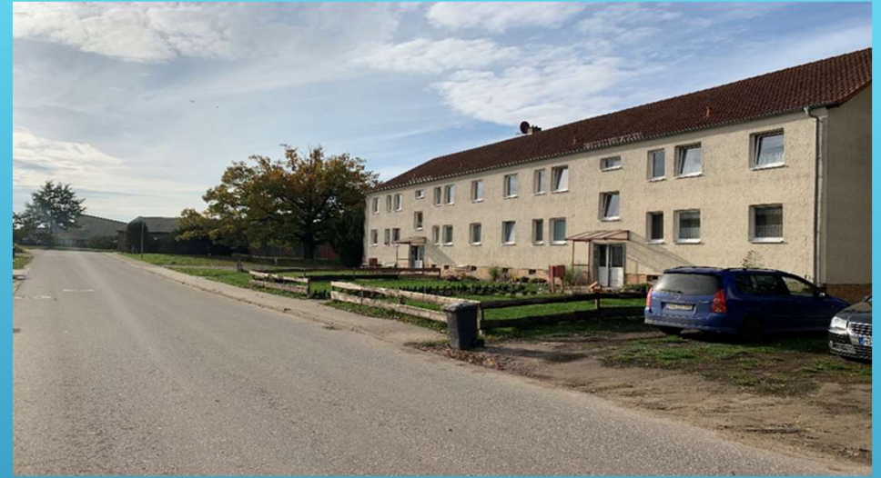
Haus-Nr. 3-5 vor der Sanierung
