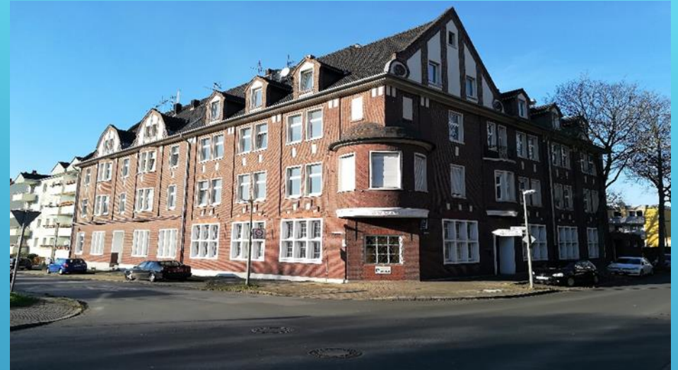
Objektfoto vor der Sanierung
