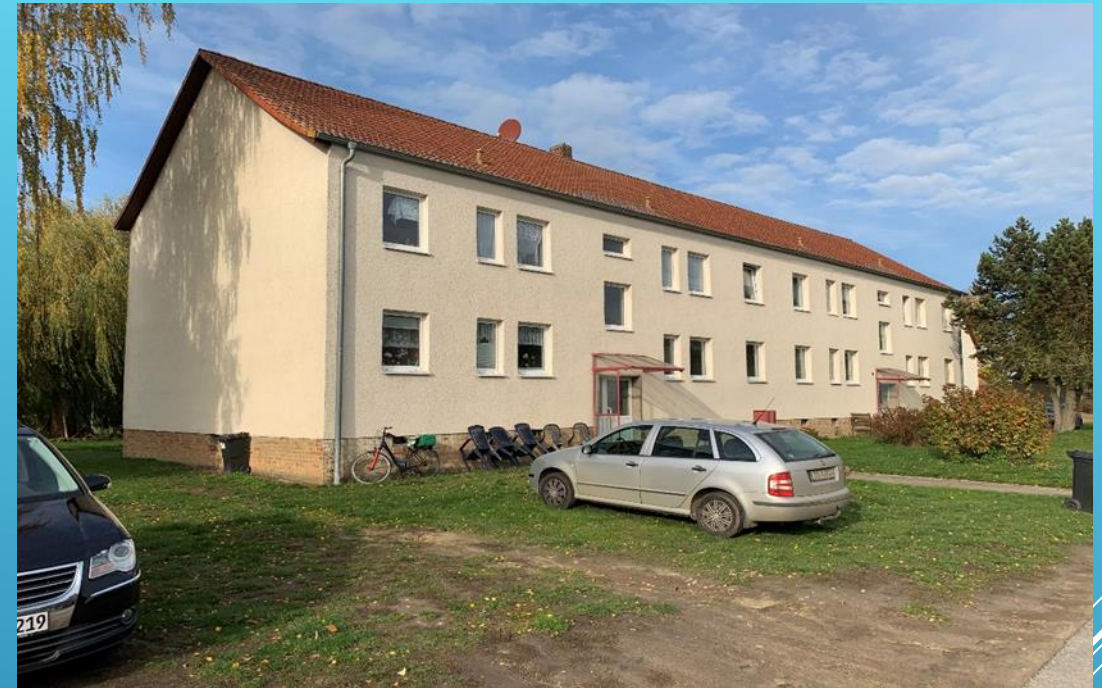
Haus-Nr. 7-9 vor der Sanierung
