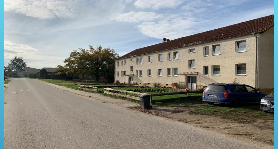
Haus-Nr. 3-5 vor der Sanierung
