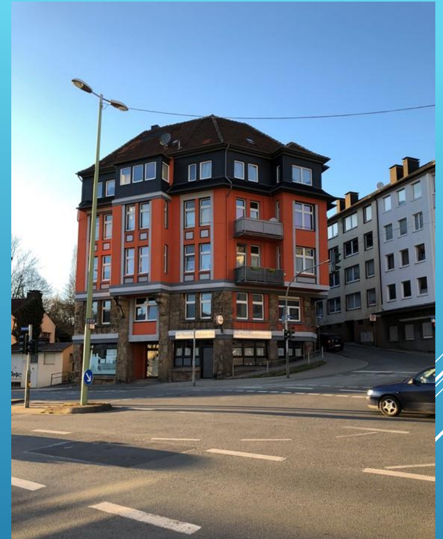
Objektfoto vor der Sanierung
