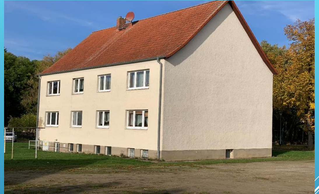
Haus-Nr. 11 vor der Sanierung
